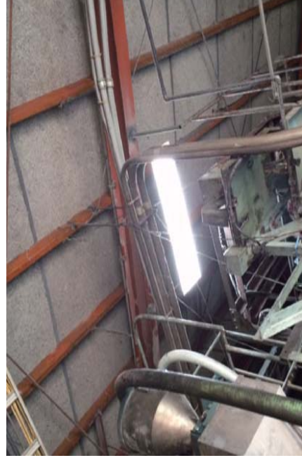
機械操作も明るく安全に
